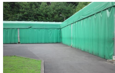
テント木型倉庫
